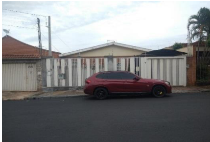
Representação Fachada Principal Descrição Data Foto
