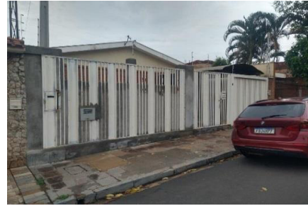
Representação Fachada Principal Descrição Data Foto
