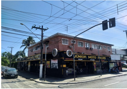
Representação Fachada Principal Descrição Data Foto 02/01/2023
