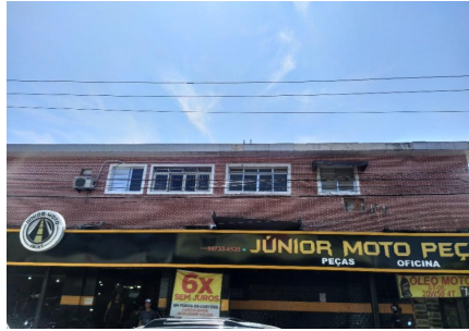
Representação Fachada Principal Descrição Data Foto 02/01/2023
