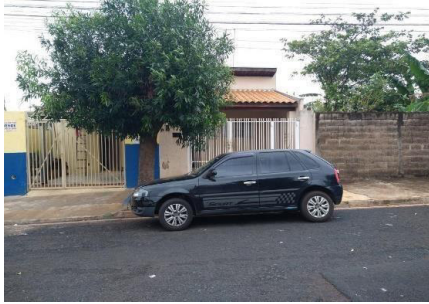
Representação Fachada Principal Descrição Data Foto
