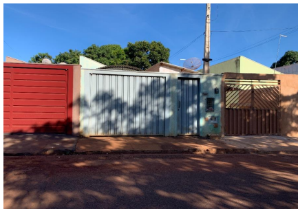
Representação Fachada Principal Descrição Data Foto 18/01/2023
