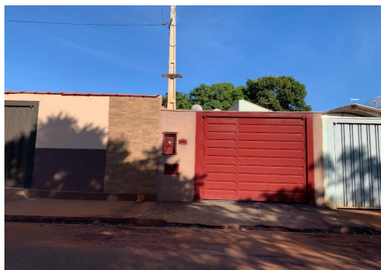
Representação Fachada Principal Descrição Vizinho esquerdo Data Foto 18/01/2023
