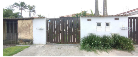
Representação Vista da Rua Descrição VIZINHO DIREITO Data Foto 29/11/2022
