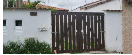
Representação Fachada Principal Descrição Data Foto 29/11/2022
