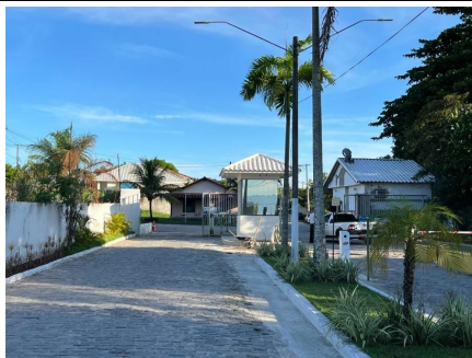
Representação Fachada Principal Descrição
