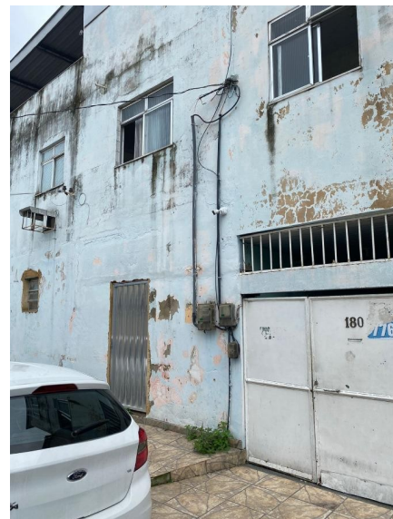
Representação Fachada Principal Descrição Data Foto 17/12/2021
