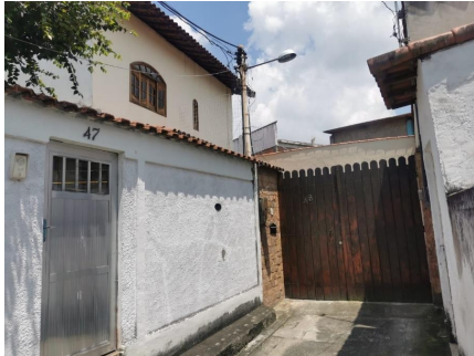
Representação Fachada Principal Descrição Data Foto 24/01/2022
