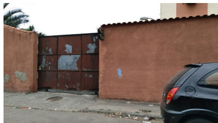
Representação Fachada Principal Descrição Acesso garagem
