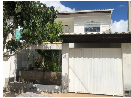
Representação Vista da Rua Descrição Vizinho direito Data Foto 10/05/2021
