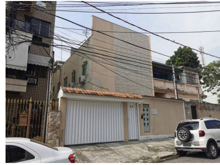
Representação Fachada Principal Descrição Data Foto 14/09/2021
