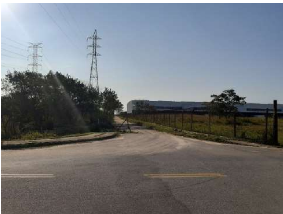
Acesso à Estrada de Servidão para quem vem da BR-101
